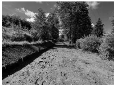
STAVBA CYKLOSTEZKY ŘIVNÁČ
