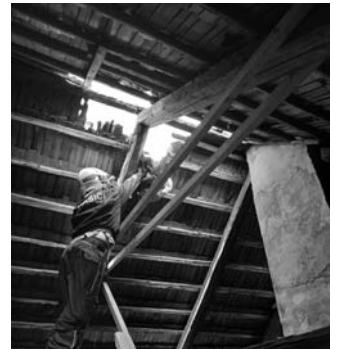
NAŠI DOBROVOLNÍ HASIČI PŘI NEDĚLNÍ OPRAVĚ STŘECHY
