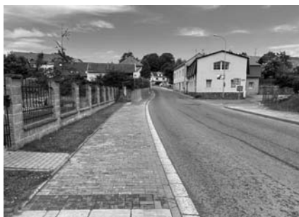
OPRAVENÝ CHODNÍK V ULICI PALACKÉHO
