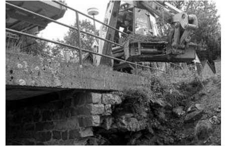
OPRAVA SUEZU BYLA ZAHÁJENA 20. SRPNA 2019
