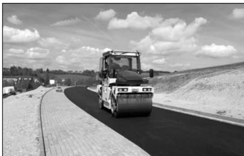
Pokládání asfaltového koberce na Slunném vrchu
