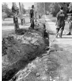
VE SVRATCE SE KABELIZUJE
